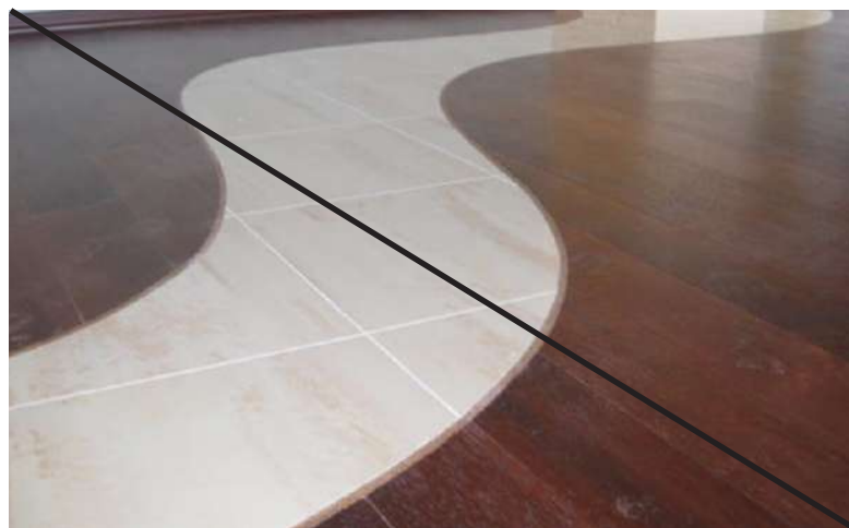
Плохо Узорные стыки из разных материалов
